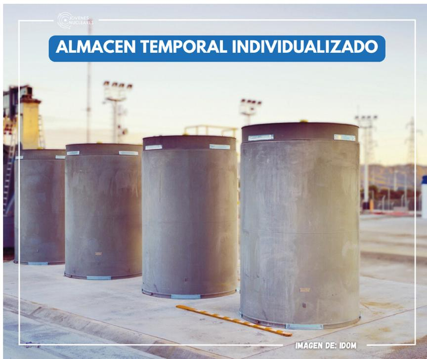
*Figura 6.4b: ATI de combustible gastado en el propio emplazamiento de la central.*
