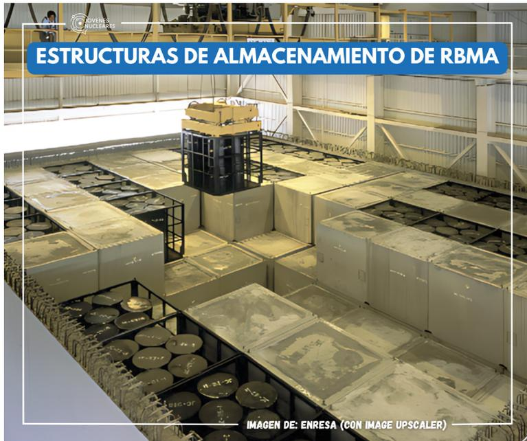
Figura 6.3b: celda de almacenamiento de RBMA.
