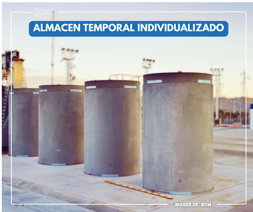
*Figura 6.4b: ATI de combustible gastado en el propio emplazamiento de la central.*
